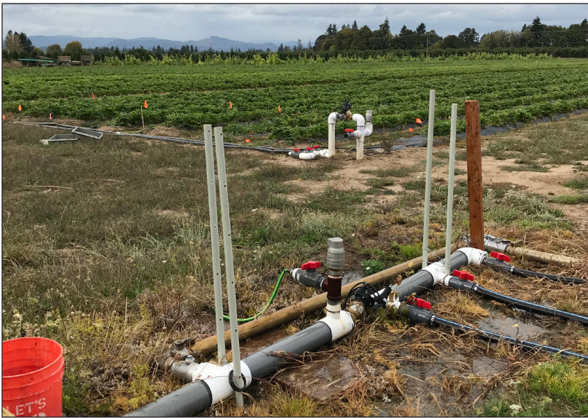
Figura 8. Sistema de fertirrigación (aplicación de fertilizante líquido a través del sistema de riego por goteo, en fresas de día neutro).
